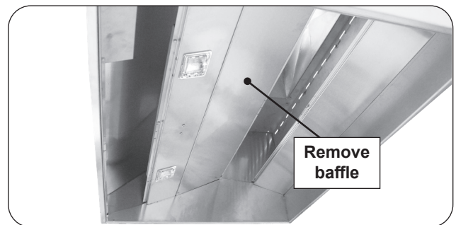
Fig. 12-2 Remove baffle
